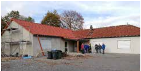
Fleißige Elche: Das Ende der Sanierung des Musiktreffs ist in Sicht.
